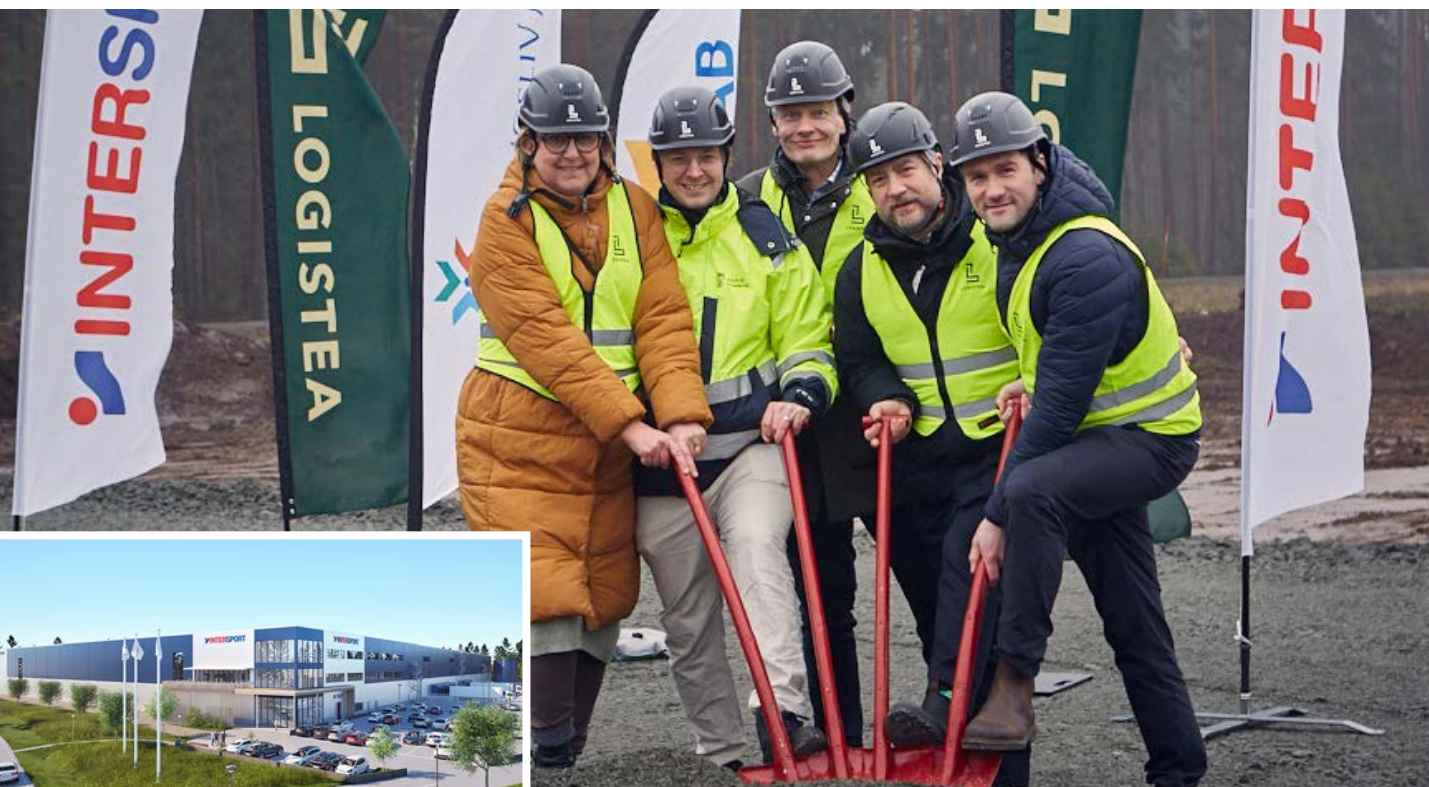
I november blev det klart att Intersport förlägger sitt nya nationella lager till Forserum, spadtaget togs strax efter årsskiftet och bygget ska vara klart för inflyttning vintern 2025. Byggnaden uppförs och ägs av Logistea och omfattar 31 000 kvadratmeter.
